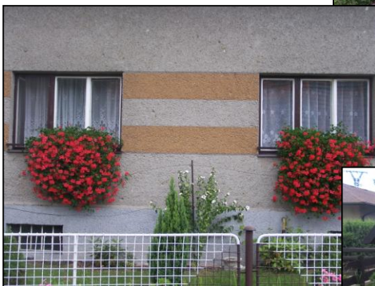
1. místo kat. okna a fasáda domu
